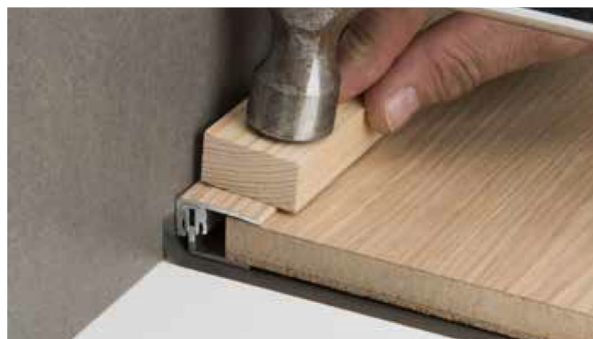
Instalace ukončovacího profilu hliníkového
